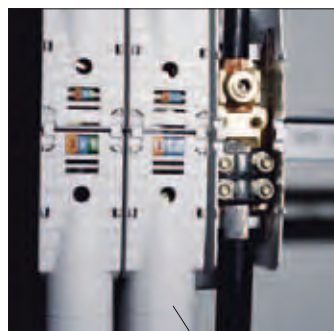
Соединение медных и алюминиевых проводников
