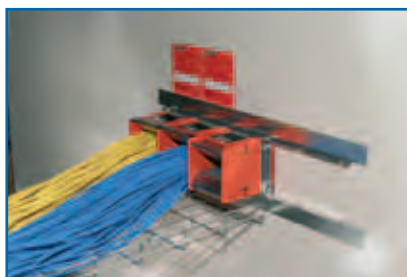
Проход кабельной трассы через стену при помощи уникальных огнестойких модулей EZ-Path
